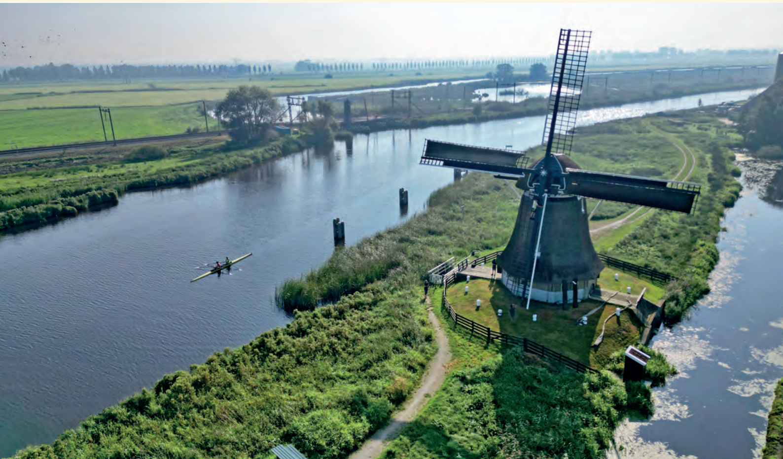
Grevensmolen in Vegelinsoord tijdens het aanbrengen van de windborden en het ophangen van de zeilen na een schilderbeurt (dronefotograaf Marco Wols, 9 september 2023).
