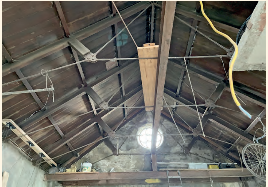
Polonceau-spanen bestaande uit houten spantbenen en stalen trekstangen en koppellementen (foto auteur, 21 oktober 2023).
